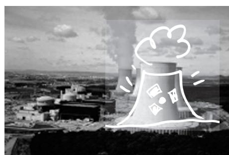
Le site de Cattenom abrite la centrale nucléaire exploitée par EDF dans le département de la Moselle, à 5 km de Thionville. Le site se trouve à 10 km du Luxembourg et de l'Allemagne. Cette centrale nucléaire est constituée de 4 réacteurs à eau sous pression d'une puissance de 1300 MWe. Les réacteurs 1, 2, 3 et 4 constituent respectivement les installations nucléaires de base (INB) 124, 125, 126 et 137.
